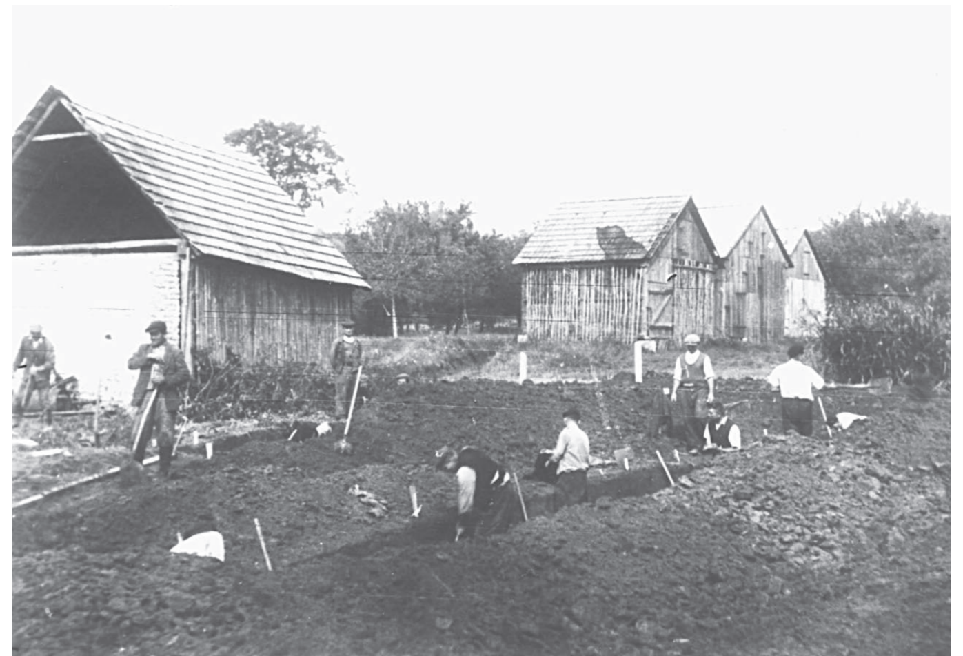
Výkopové práce pre novú školskú budovu
